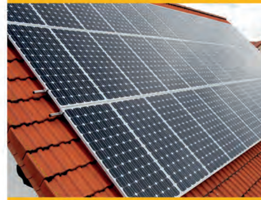
Aufdach-Montage der Solarmodule
