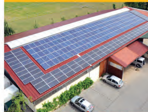
Nutzgebäude mit Modulen in Süd-Ausrichtung
