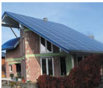
17kW-Anlage, Aufdachanlage (Deutschland) 17kW Installation (Germany)
